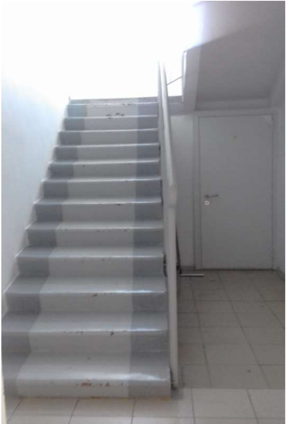
№6 - Лестница внутри здания
