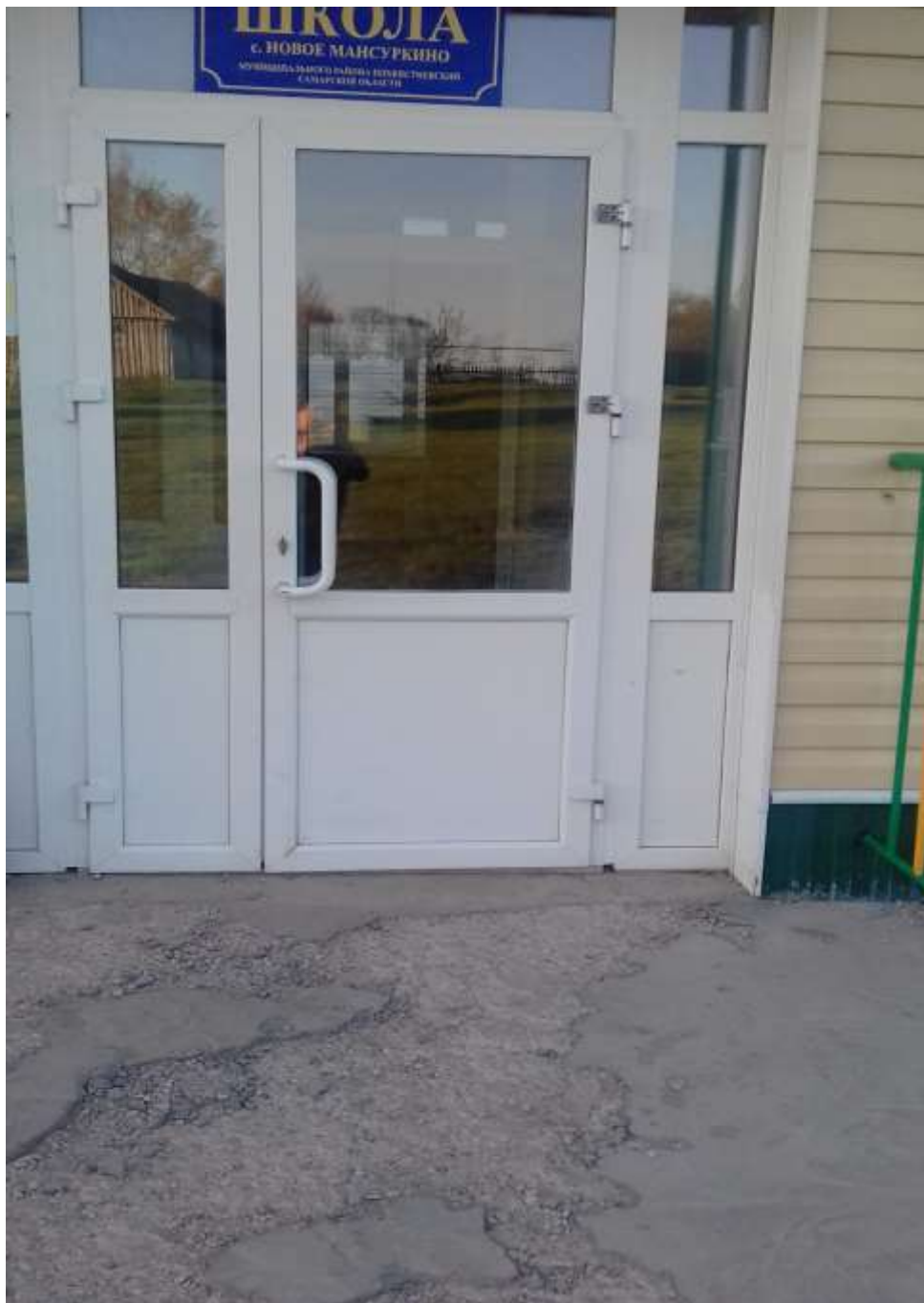
№ 3 – Входная площадка. Дверь входная
