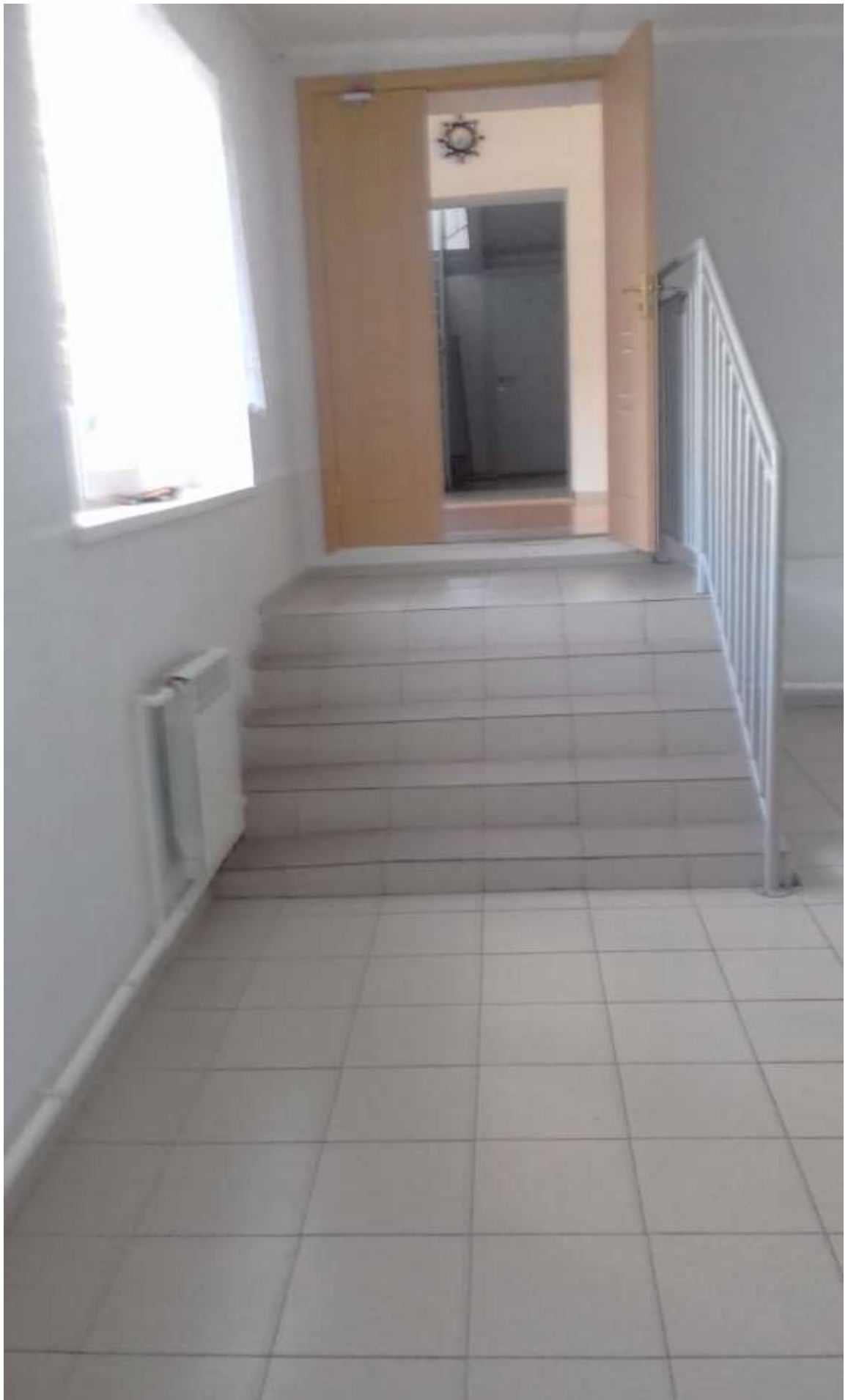
№8 – Дверь внутри здания
